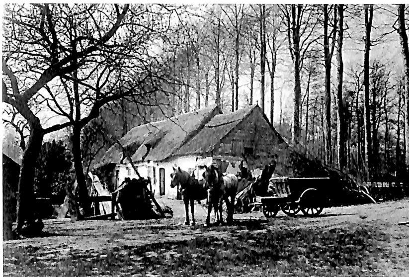
Maison dite "des voleurs" à la lisière du bois.
